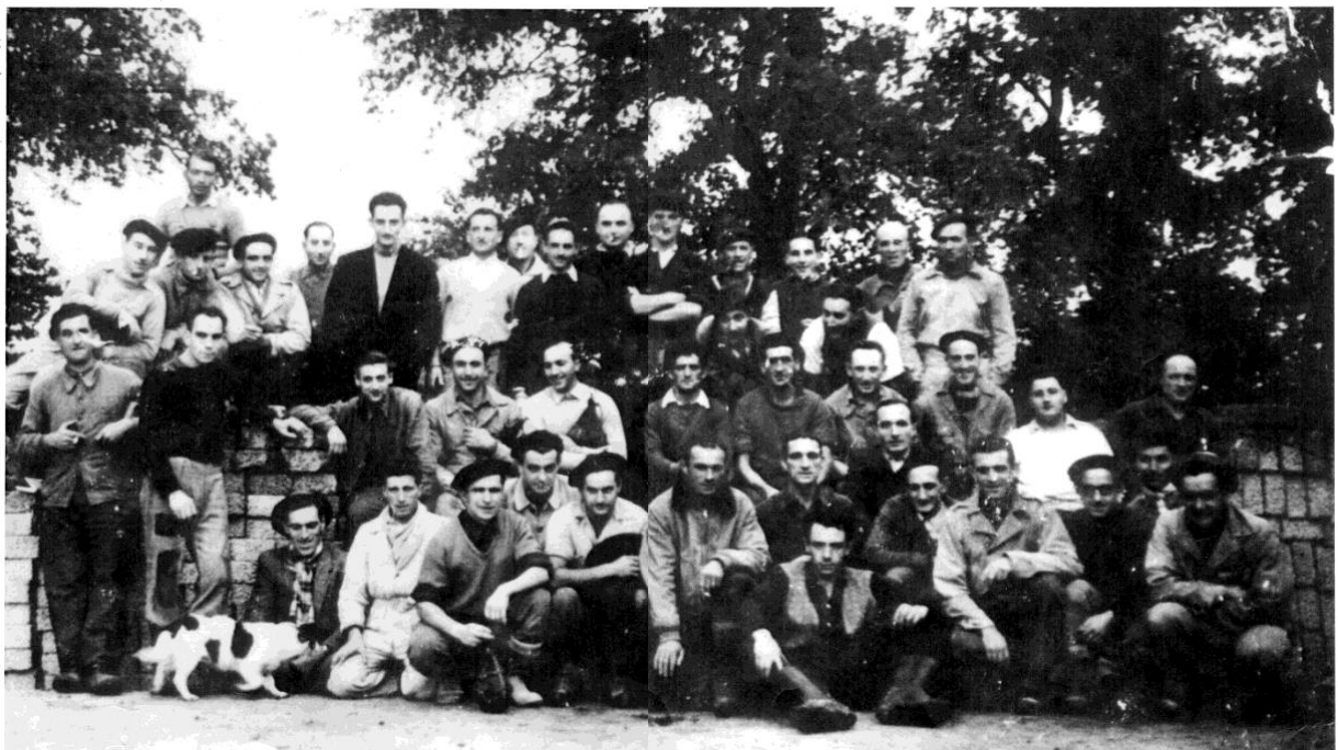
Groupe de Bâtisseurs réunis pour travailler un W.E. sur le chantier des Castors de Mérignac
