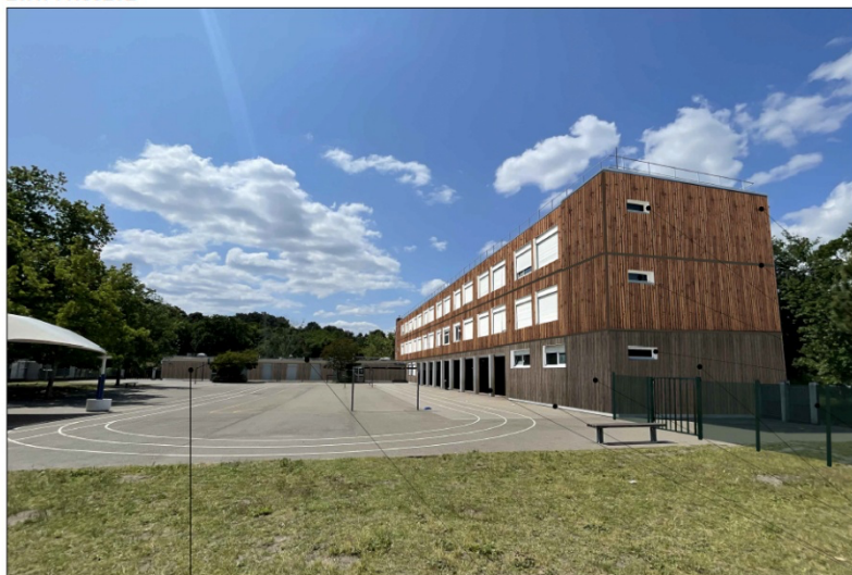
Bardage lames larges, essence mélèze Profil 2.0 de chez Orto, teinte gris Bandeau à remettre en peinture
