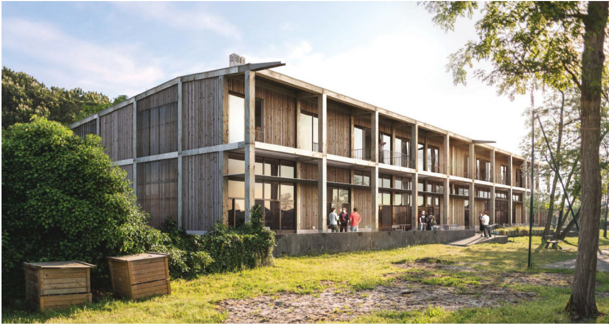
Vue de la nouvelle façade Sud depuis le parc Sublimier la trame esthétique existante
